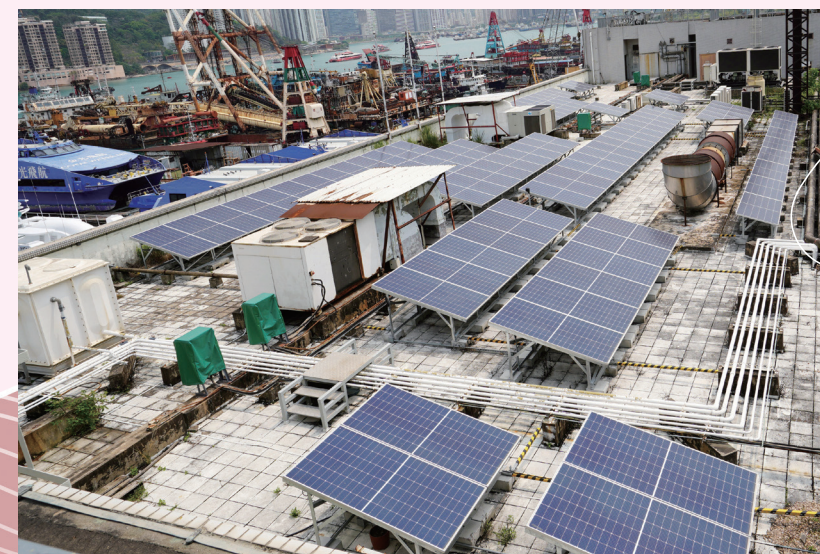
於總辦公室天台及船廠屋頂安裝太陽能光伏系統。
